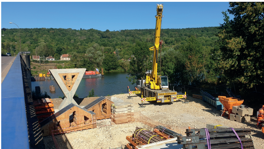
Pose de la première pile en août 2022
