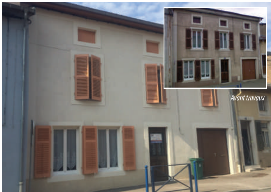
Façade rénover à Arnaville
