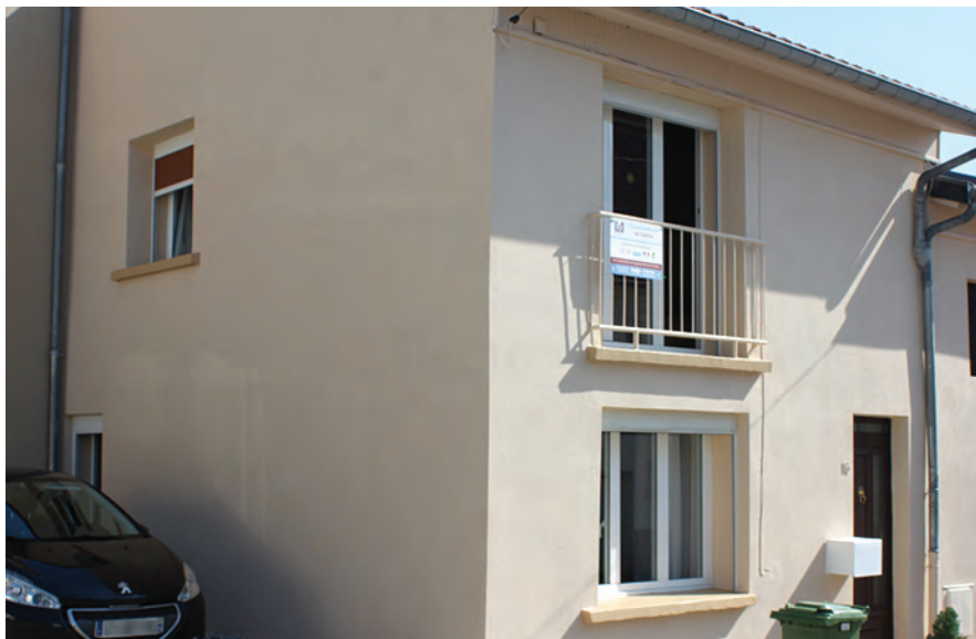
Façade rénovée à Novéant sur Moselle
