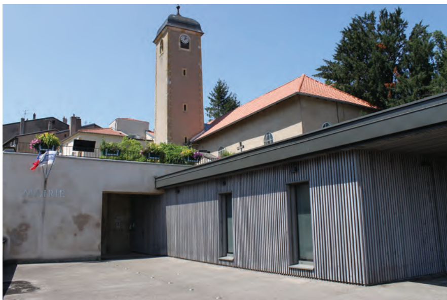
Durant les travaux à l'ancienne gare d'Ancy-Dornot, les services sont transférés à la mairie de Dornot
