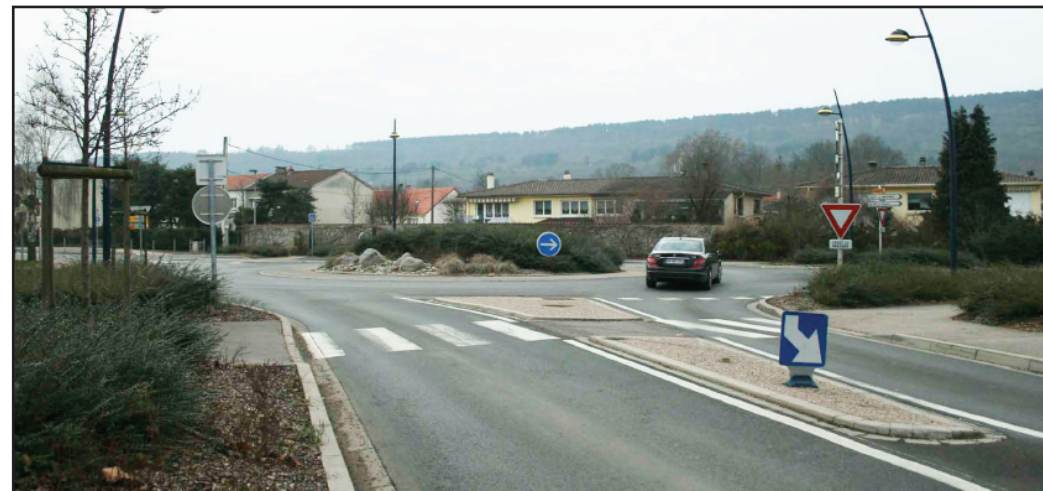
vue sur le giratoire au croisement de la RD 657 (Jouy-aux-Arches) et RD 66 (Fey)
