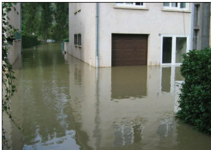
image d'inondation en centre-bourg (octobre 2006)
