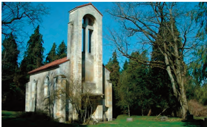
Village détruit de Remenauville
