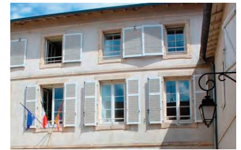
Logements à Thiaucourt
